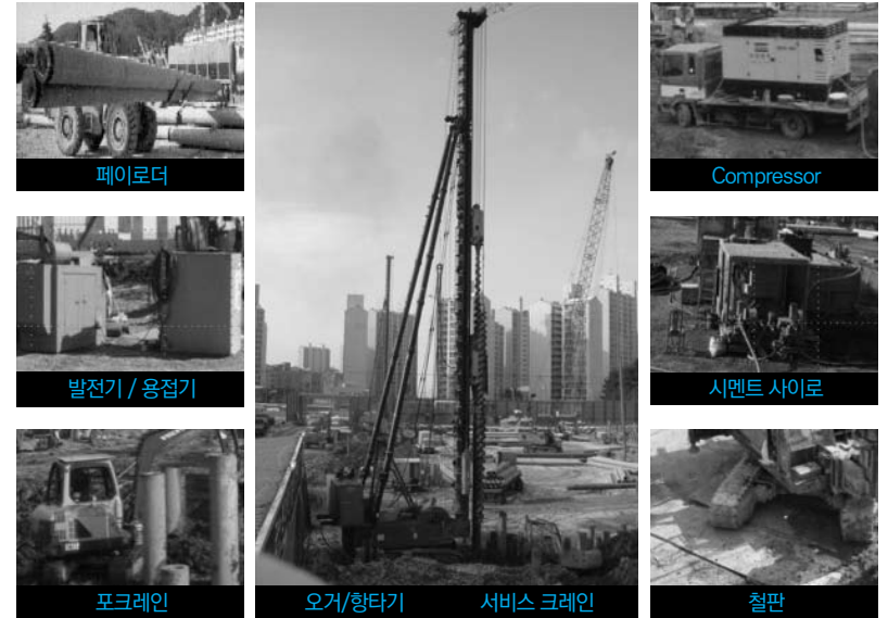
연약지반인 군산지역 파일 공사현장과 장비구성
